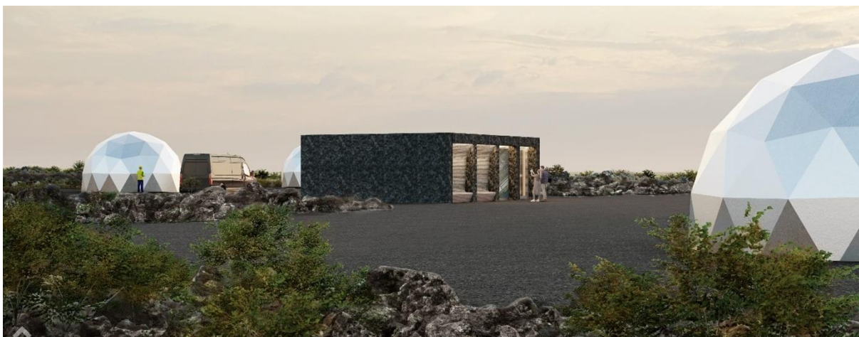
MYND 8.52 Mögulegt útlit borteigs á mörkum þegar byggðs svæðis og opins svæðis. Fyrir miðju má sjá hugmynd að útliti stjórnbyggingar á borteig, í for- og bakgrunni má sjá skýli yfir niðurdælingarholum. Mynd: Nordic Office of Architecture, 2024.
