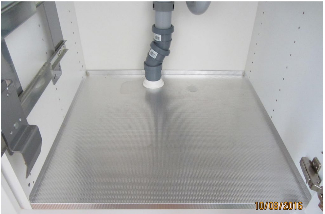
Mynd 2. Vatnspéttur botn undir vaski.
