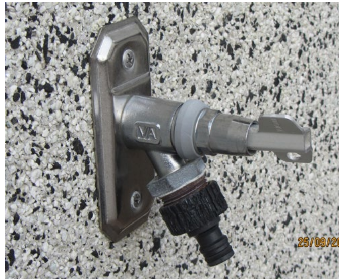
Mynd 3. Garðkrani með frostöryggi
