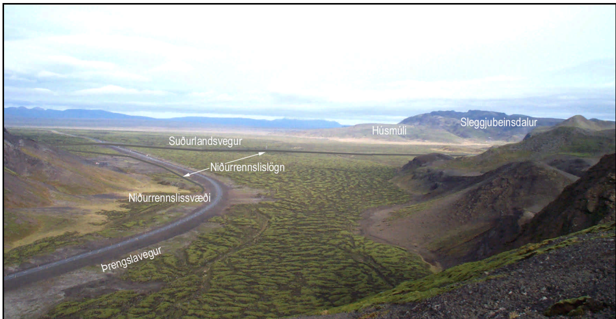
Mynd 50. Horft til norðurs yfir niðurrennslissvæði og lagnaleið í Þrengslum.
