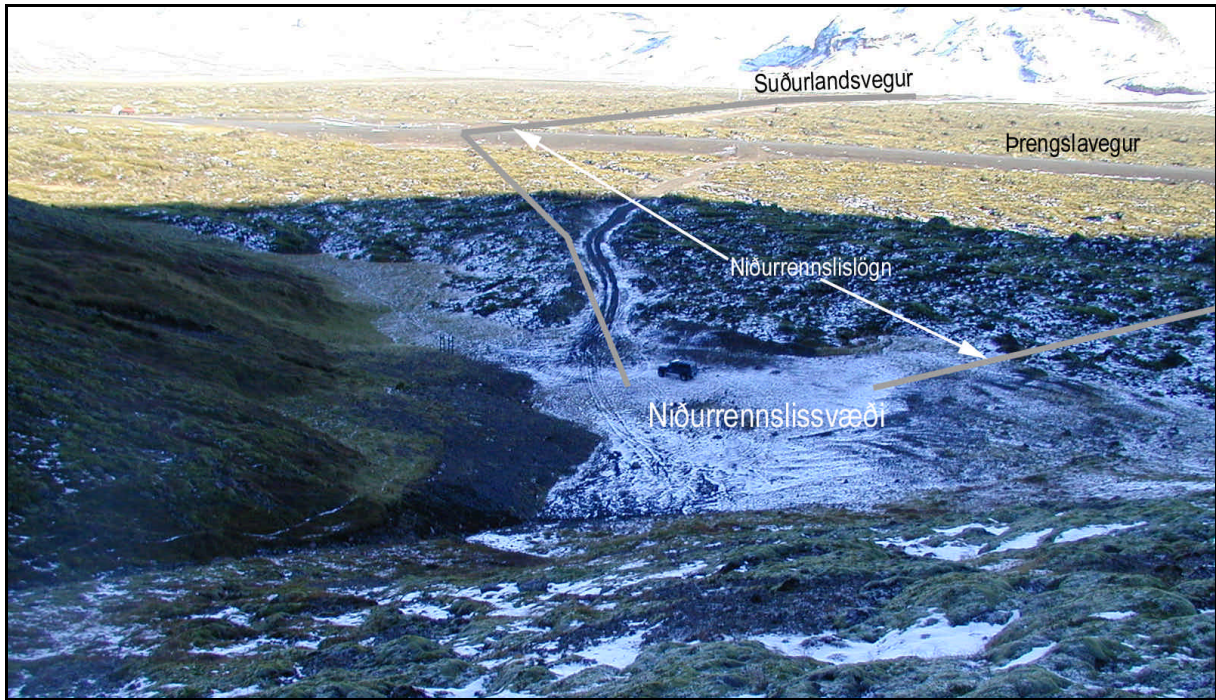
Mynd 49. Niðurrennslissvæði við Lambafellshnúk og lagnaleið yfir Svínahraun horft til austurs.
