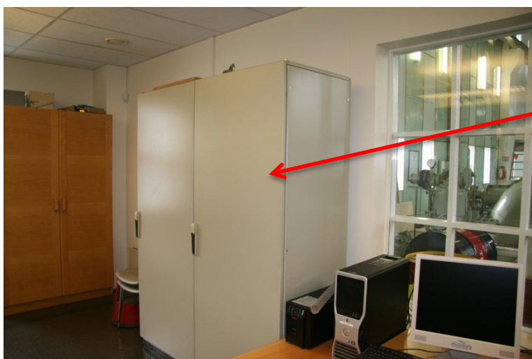
Mynd 14 Iðntölvuskápur í stjórnherbergi
