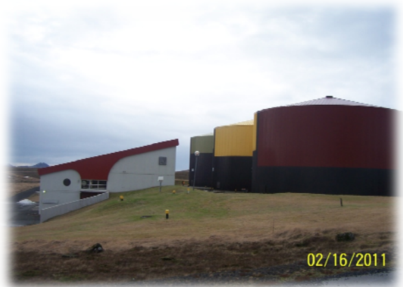
Mynd 19 Forðatankar og dælustöð að Fitjum í Reykjanesbæ
