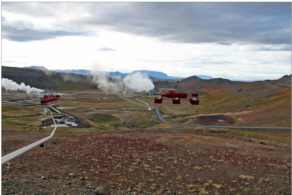
Mynd 9.34 Ásjón frá útsýnispalli, norðan Kröflustöðvar með tilkomu Kröfluvirkjunar II. Kæliturnar nýju virkjunarinnar eru sýndir án gufu til að skyggja ekki á önnur virkjunarmannvirki.
