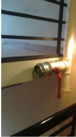
Mynd 4. Dæmi um ófullnægjandi uppsetningu slöngutengis. (Ath. Nota skal renniloka og athafnasvæði slöngutengis skal fylgja reglum MVS.)
