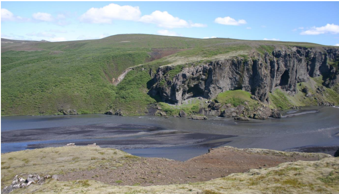
Mynd 1. Stíflustæði Hólmsárlóns við Atley. Horft er til norðausturs frá Atley.
