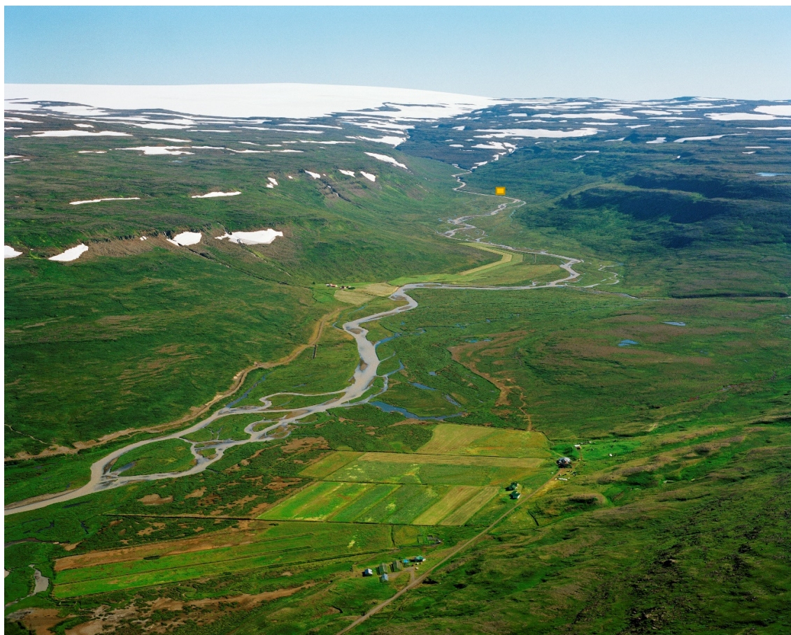
Mynd 3-1: Skjaldfannardalur, bæirnir Laugaland t.h. og Skjaldfönn t.v. ásamt mögulegu stöðvarhúsi (gult).
