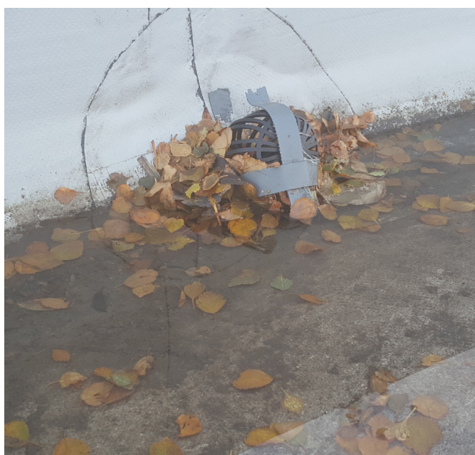
Mynd 13. Hreinsa þarf lauf frá laufgildrum svo vatn komist óhindrað ofan í regnvatnslögn.
