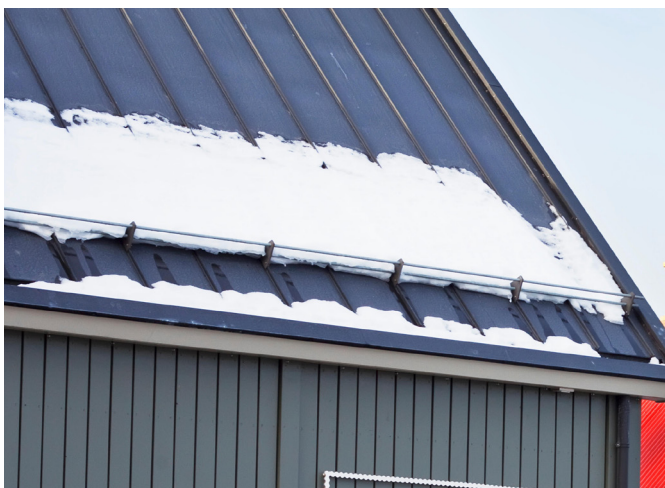
Mynd 6. Þakgrind með tveimur rörum á festingu fyrir málmplötuklæðningu í Bankastræti.
