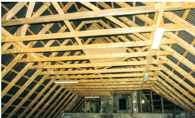
Mynd 19. Bárújárn neglt á lektur á Korpúlfsstöðum á síðustu öld.
