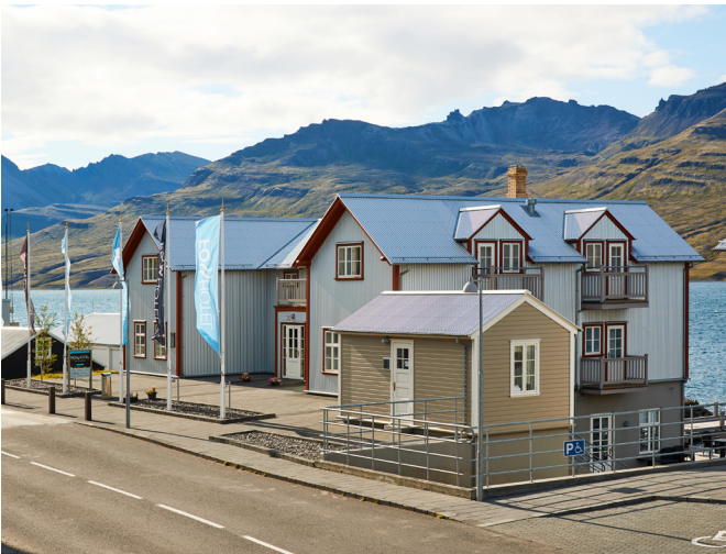
Mynd 25. Kvistir inni á þakfleti ásamt snjohengjuvörnum við þakbrún á Fáskrúðsfirði
