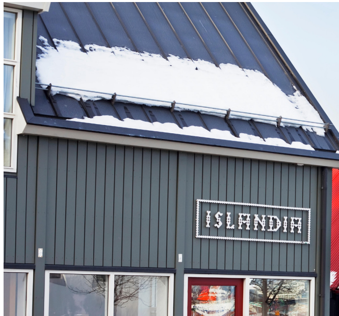
Mynd 7. Þakgrind með tveimur rörum á festingu fyrir málmplötuklæðningu í Bankastræti.
