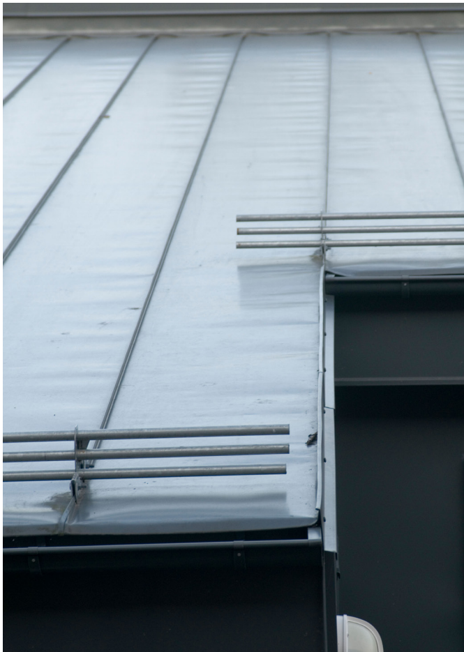
Mynd 5. Dæmi um þakgrind með þremur rörum á festingu fyrir málmplötuklæðningu.
