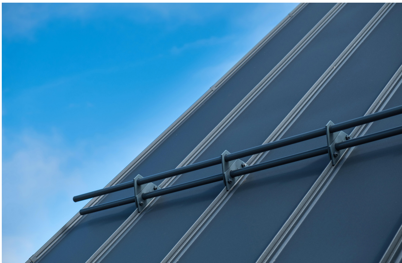
Mynd 1. Þakgrind með tveimur rörum á festingu fyrir málmplötuklæðningu.
