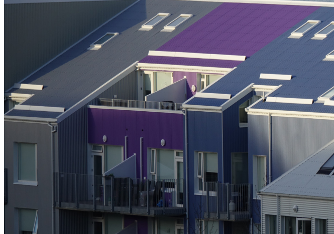
Mynd 8. Þakgrindur úr blikki staðsettar lítið eitt inni á þakinu, um það bil yfir útveggnum.
