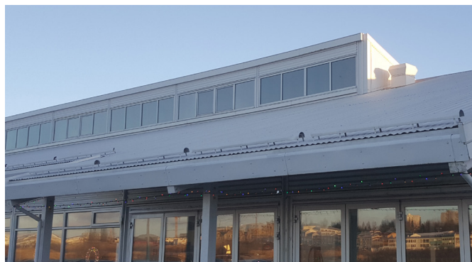
Mynd 9. Þakgrindur úr blikki beygðu í hálfmána á festingum sem lyfta grindunum nokkra sentimetra frá þakklæðningunni.
