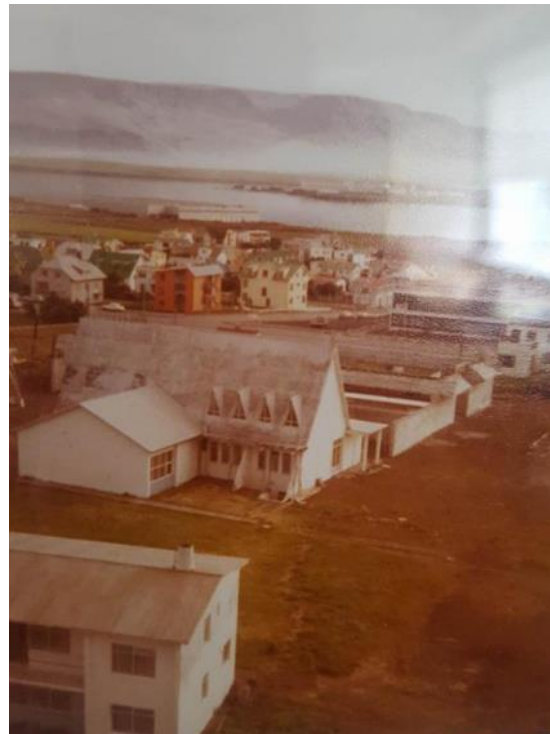
Mynd 1 Frá byggingu Langholtskirkju
