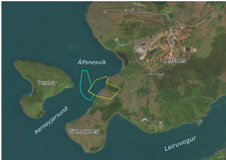
Mynd 2.1: Loftmynd af Álfsnesi og Þerney sem sýnir staðsetningu fyrirhugaðrar framkvæmdar í Álfsnesvík, svæði fyrir landfyllingu og athafnasvæði á landi (gul brotalína) og dýpkunarsvæði vegna innsiglingarrennu og snúningssvæðis.
