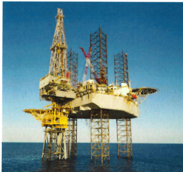
Mynd 8: Borvallur á sjó. Sér pallur (guli pallurinn á myndinni) er m.a. fyrir holutoppna. Borvallurinn við hliðina og borinn sjálfur verða fjarlægðir að borverki loknu.
