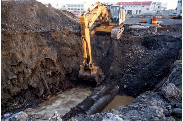
Október 1996. Grafíð ofan af Ánanaustaræsi í þeim tilgangi að setja það í steyptan stökk til styrkingar.
