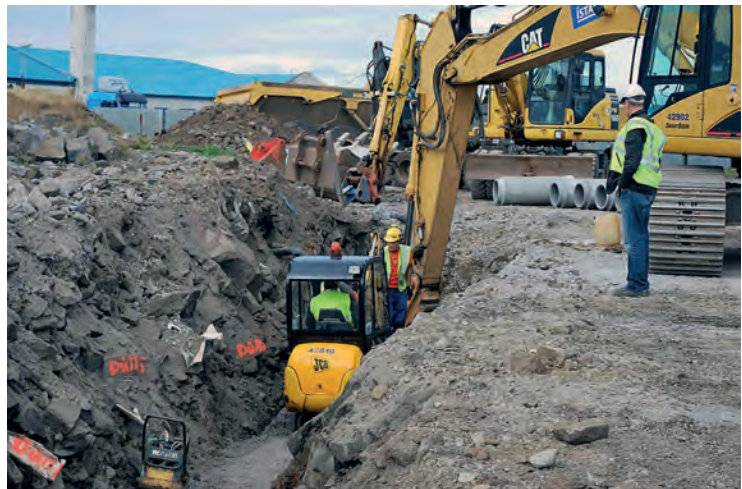
Unnið í fráveituskurði á Akranesi sumarið 2009.
