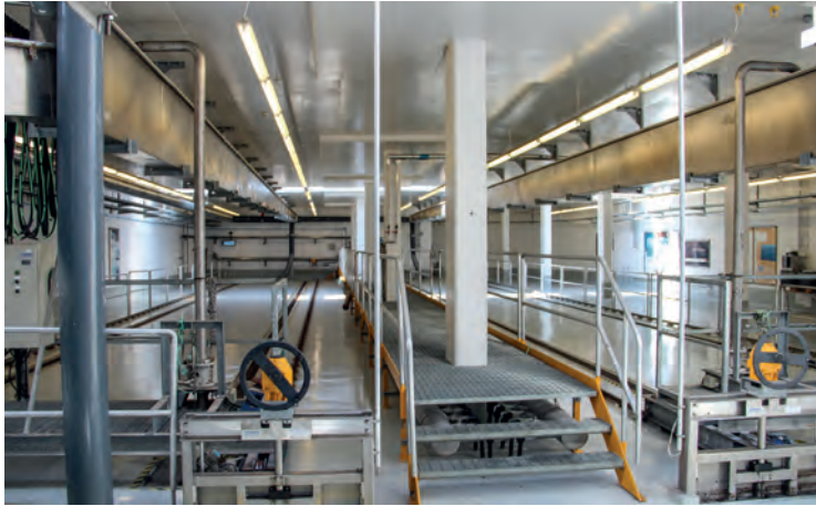
Eftir síun fer skólpið í sérstakar sand- og fituskiljur.
