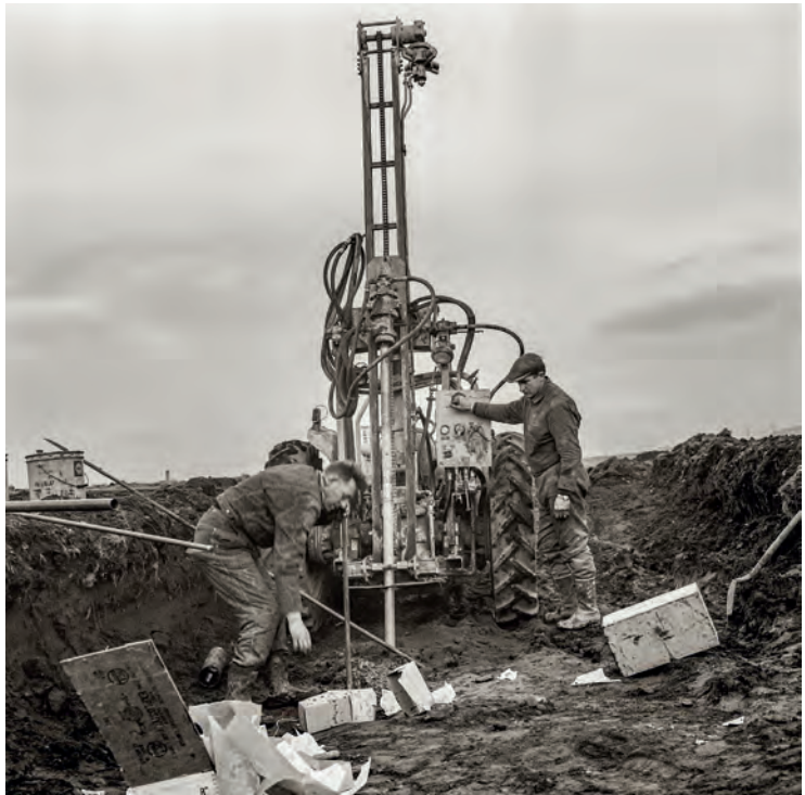
Notaður var bor til að koma fyrir sprengiefni. Á myndinni eru bormennirnir Magnús Guðmundsson og Guðmundur Oddsson. Febrúar 1964.
