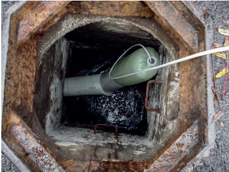
Plastsokki komið fyrir í gamalli lögn með þrýstingi.
