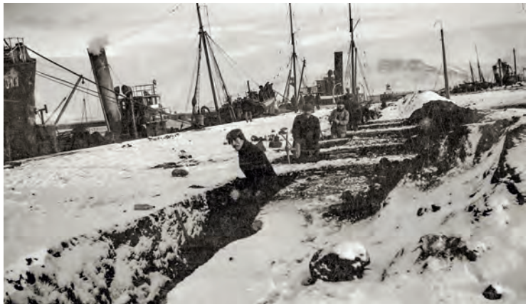
Skurðgröftur við Austurbakka Reykjavíkurhafnar 1925–1928. Hér er líklega verið að grafa fyrir sniðræsinu sem hafði útrás í krikanum fyrir austan Ingólfsгарð og veitti öllu skólpi út fyrir höfnina.
