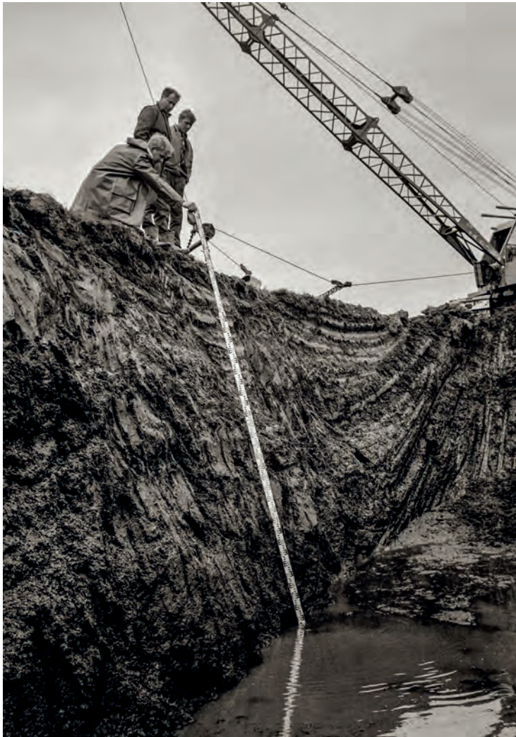
Grafa þurfti 4–5 metra niður til að komast á fast eða jafnvel enn dýpra. Fremst á myndinni er Þorvarður Sigurðsson verkstjóri. Júlí 1966.
