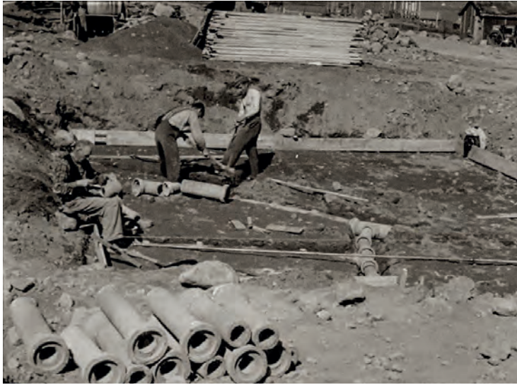
Holræsi lögð í húsgrunn. Í nýrri reglugerð um holræsi árið 1960 voru gerðar mun strangari kröfur en áður um frárennsliskerfi og lagnir í hús.
