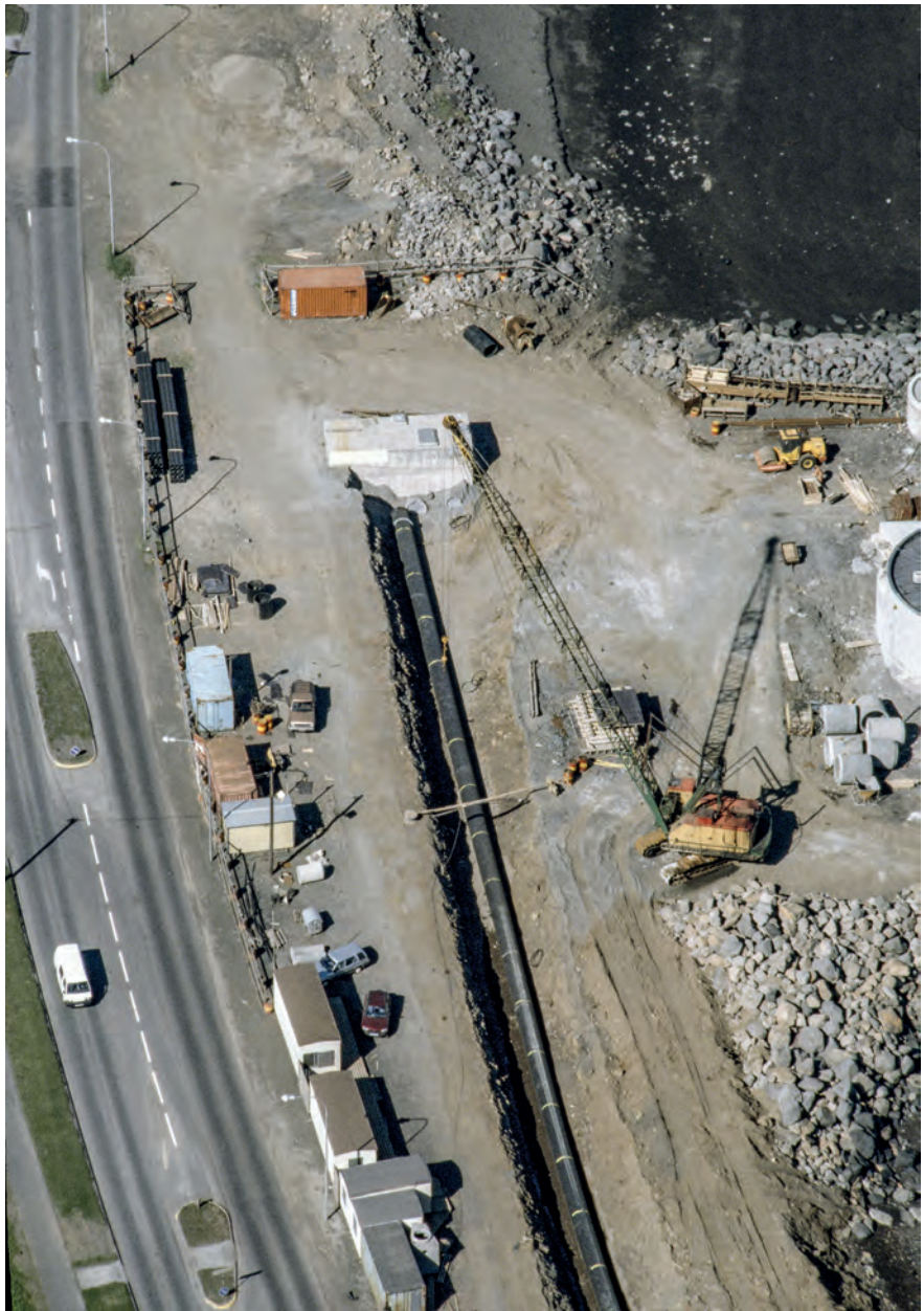
Lagning þrýstilagrar meðfram ströndinni á mótis við dælustöðina við Boðagranda í júní 1997.
