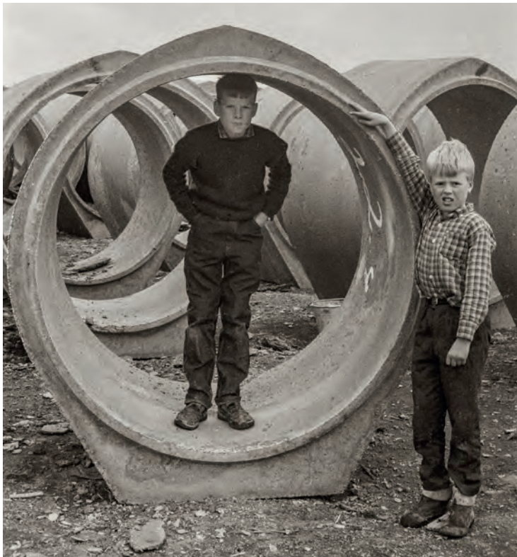
Alls fóru 7.000 rör, öll steipt í Pipugerð Reykjavíkur, í Fossvogsræsið. Þau víðustu, sem hér sjást, voru 140 sentimetrar á vídd.
