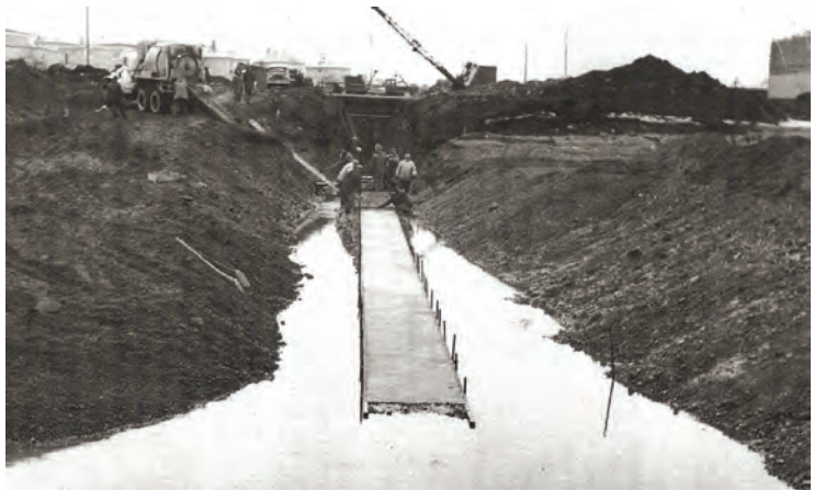
Kringlumýrarræsið. Botnplatan steipt.
