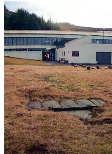
Gömul rotþró á Varmalandi í Borgarfirði. Síðar reisti Orkuveita Reykjavíkur lífræna hreinsistöð á staðnum.
