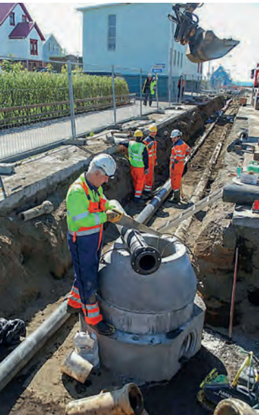
Unnið við fráveituframkvæmdir á Akranesi en gamla holræsakerfið þar var töluvert laskað.
