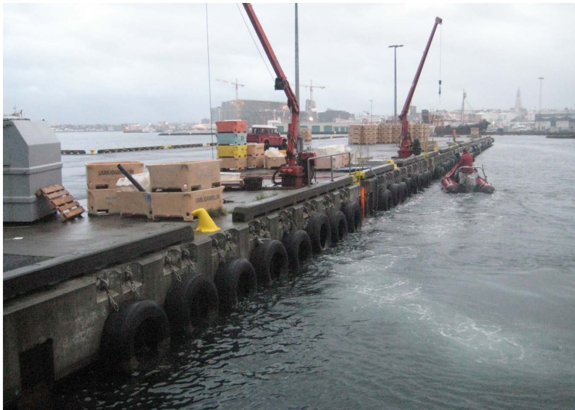
Mynd 33: Reykjavíkurhöfn 9. sept. 2010. Um 0,8 m vantaði upp á hafnarbakkann þegar hæst var.
