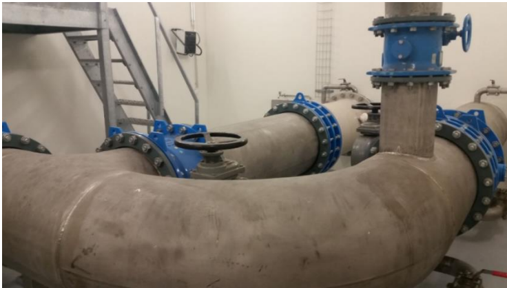
Mynd 6: Handvirkur spjaldloki á 600mm stál lögn [14]
