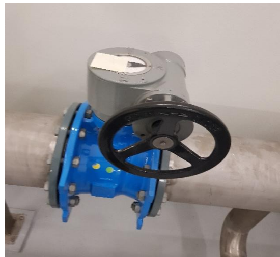
Mynd 8: Handvirkur spjaldloki á 250mm stál lögn[14]
