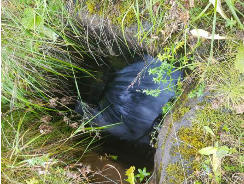
Mynd B.1: Endi inntaksins
