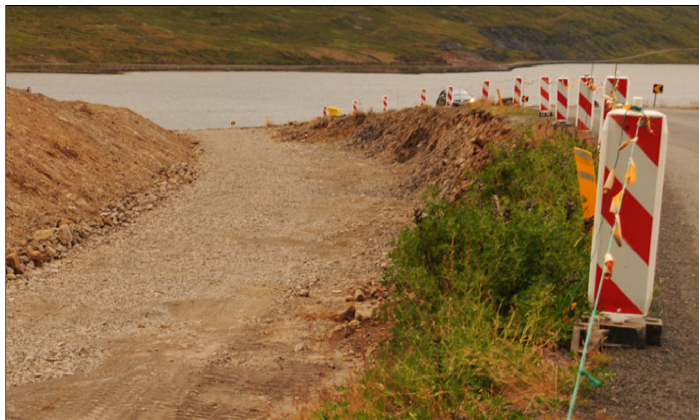
Nú standa yfir miklar framkvæmdir á Djúpvegi (61) í Hestfirði og Seyðisfirði í Ísafjarðardjúpi. Á Eiðinu á milli fjarðanna er hæðarlega vegarins lagfærð með skeringu og fyllingu. Alls er framkvæmdakaflinn 7 km langur. Nánari lýsing á þessu verki birtist í 1. tbl. þessa árs.
