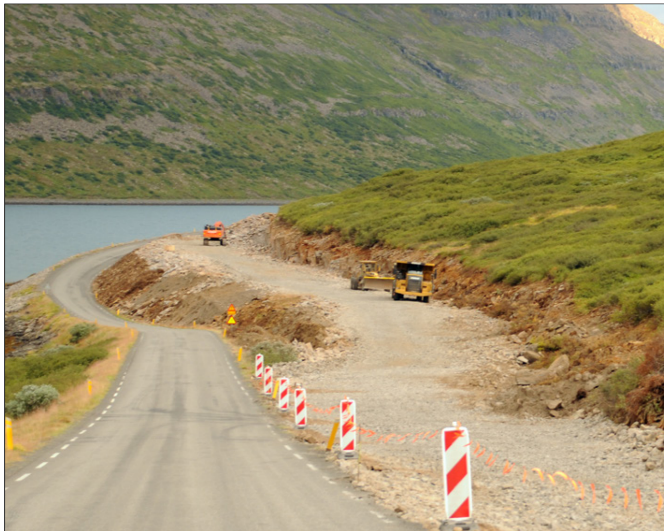
Nú standa yfir miklar framkvæmdir á Djúpvegi (61) í Hestfirði og Seyðisfirði í Ísafjarðardjúpi. Á Eiðinu á milli fjarðanna er hæðarlega vegarins lagfærð með skeringu og fyllingu. Alls er framkvæmdakaflinn 7 km langur. Nánari lýsing á þessu verki birtist í 1. tbl. þessa árs.
