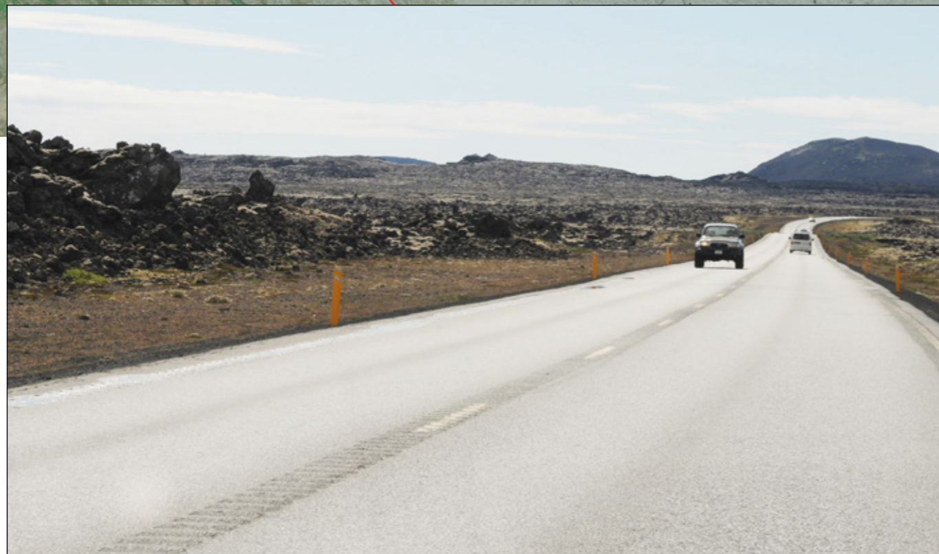
Grindavíkurvegur (43) verður breikkaður í 2+1 veg í áföngum.
