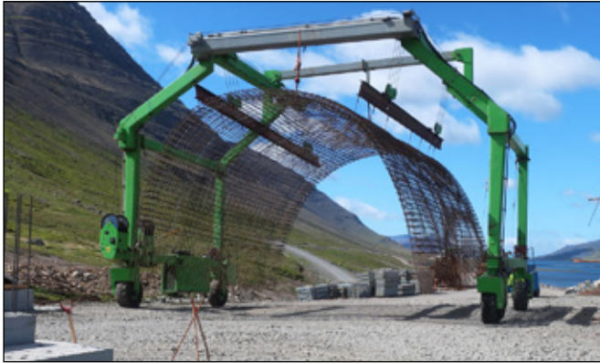
Flutningur á járngrind fyrir yfirbyggingu vegskálans 18.06.19.
