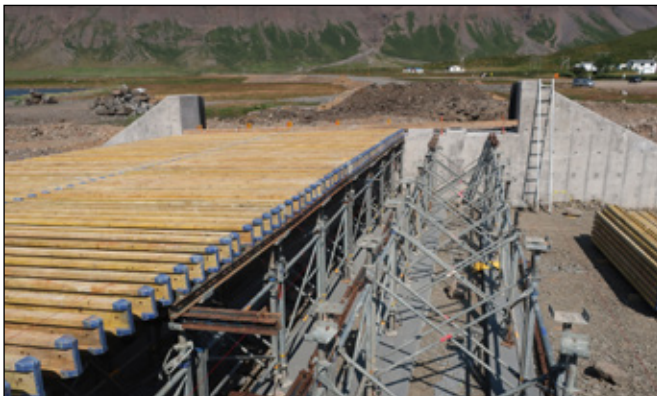
Mótaupsláttur fyrir brúargólfði á brúnni yfir Mjólka 07.07.19.
