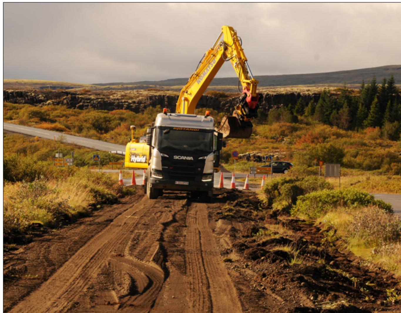
Nú eru hafinn seinni áfangi framkvæmda við endurbætur á Þingvallavegi (36), frá þjónustumiðstöðinni að vegamótum við Vallaveg austan vatns. Veginum hefur lokað fyrir allri umferð og búast má við að vegurinn verði lokaður fram á haust. Hjáleid er um Vallaveg (361). Myndirnar hér í opnunni voru teknar 12. september sl. þegar framkvæmdir stóðu yfir á fyrri áfanga.
