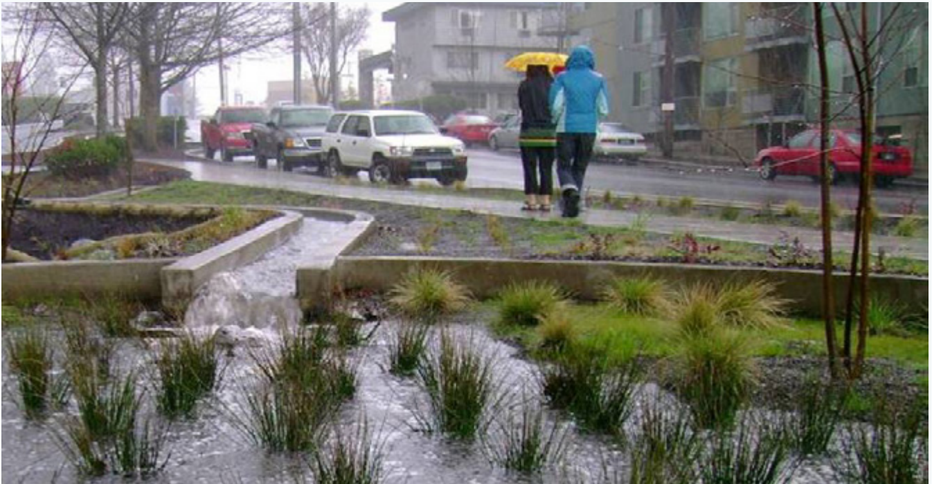
Mynd 30 Blágrænar ofanvatnslausnir hafa víða verið settar inn í göturýmið með fjölbreyttum hætti og skilað sér í grænni götumynd sem lifnar við í rigningu (Ljósmynd: Portland, Oregon).
