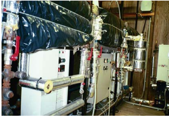
Mynd 3.3 Rásir með hitaveituvatni
