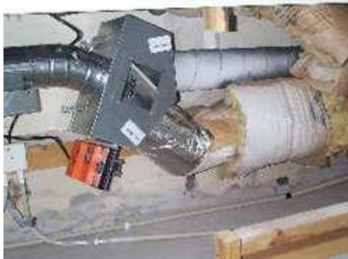
Tveggja stokka kerfi með loftmagnsboxi (Farex).
