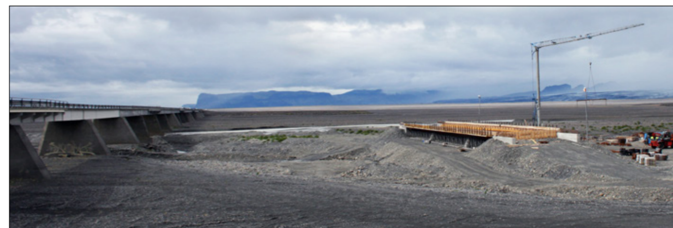
Hringvegur (1), ný brú á Morsá í byggingu 30. ágúst 2016. Til vinstri má sjá gömlu Skeiðarárbrúna..
