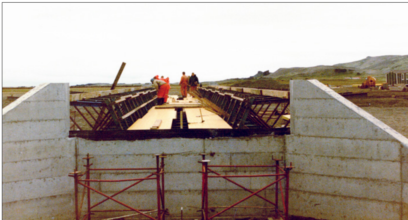
Selá í Álftafirði í byggingu 1985. Síðasta einbreiða brúin sem var byggð á Hringvegi (1).
