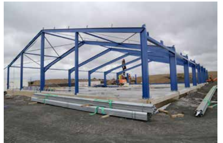
Fyrirtækið hefur byggt á annað hundrað stálgrindarhúsa.
