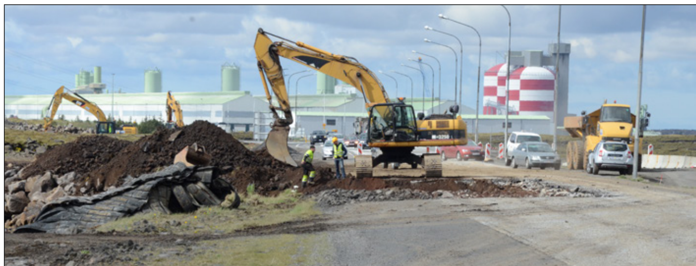
Reykjanesbraut, vegamót við Krýsuvíkurveg, framkvæmdir 31. maí 2017.
