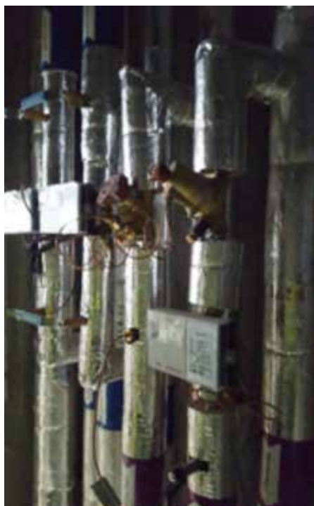
Mynd 2. Spjaldloka sem var ofaukið og lokar fyrir loftflæði inni fundarherbergi.
