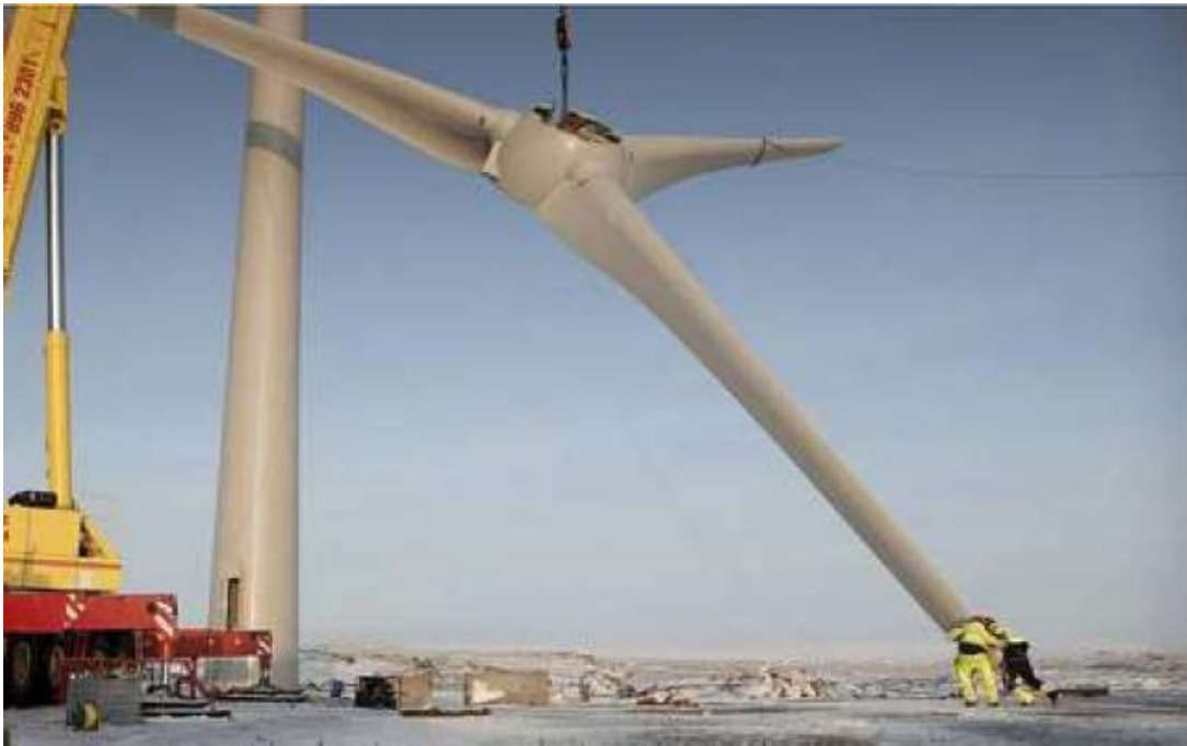
Mynd 41. Vinna við uppsetningu á vindmyllum Landsvirkjunar (Landsvirkjun, e.d.c)
