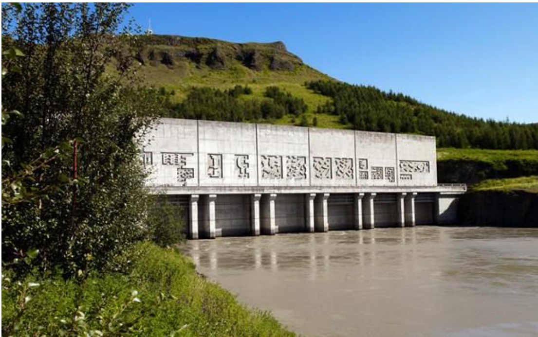
Mynd 24. Búrfellsvirkjun (Landsvirkjun, e.d.c)
