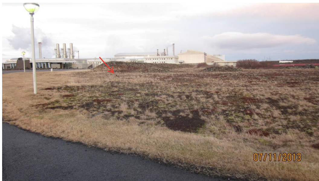
Mynd 8.3 Frágengin lokað borhola nr. 5 í Svartsengi. Rauð ör bendir á holustút sem stendur upp úr yfirborðinu. Við frágang var sáð í svæðið og landið mótað.
