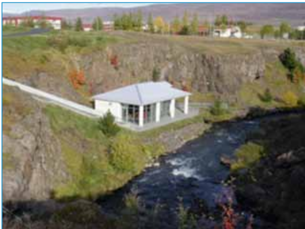
Mynd 2: Glerárvirkjun 290 kW
