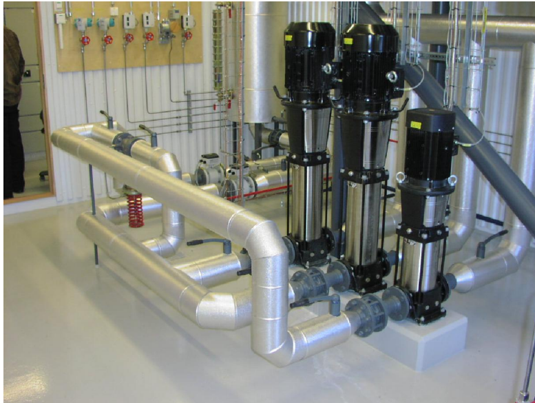
Námskeið fyrir hita- og vatnsveitur
