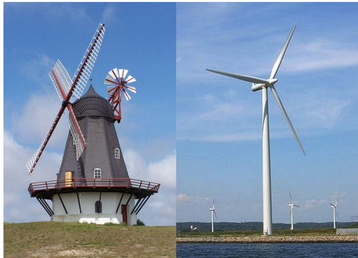
Mynd 3.5: Spaðavindmylla með viftuskotti og vindmyllur eins og þær eru í dag. [13] [14]
