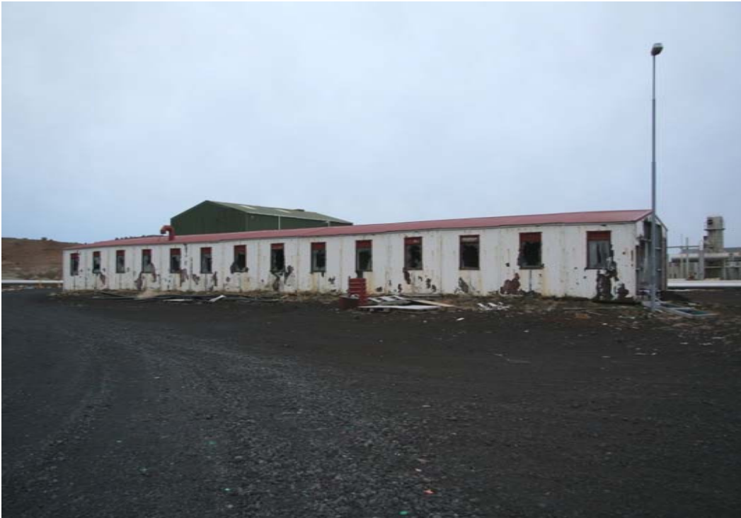
Mynd 22.8 Yfirgefnar byggingar á iðnaðarsvæði. Ljósmynd: Hjördís Árnadóttir 2008.
