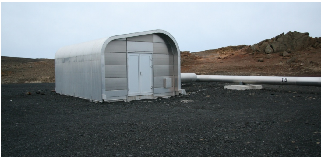
Mynd 8.4 Borholuhús við Reykjanesvirkjun.
