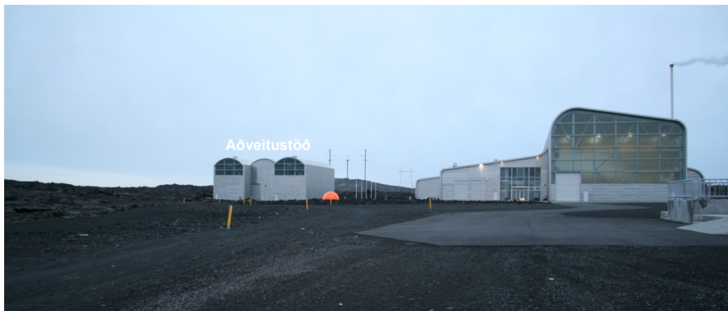
Mynd 8.10 Aðveitustöð (vinstra megin) norðan stöðvarhúss Reykjanesvirkjunar.
