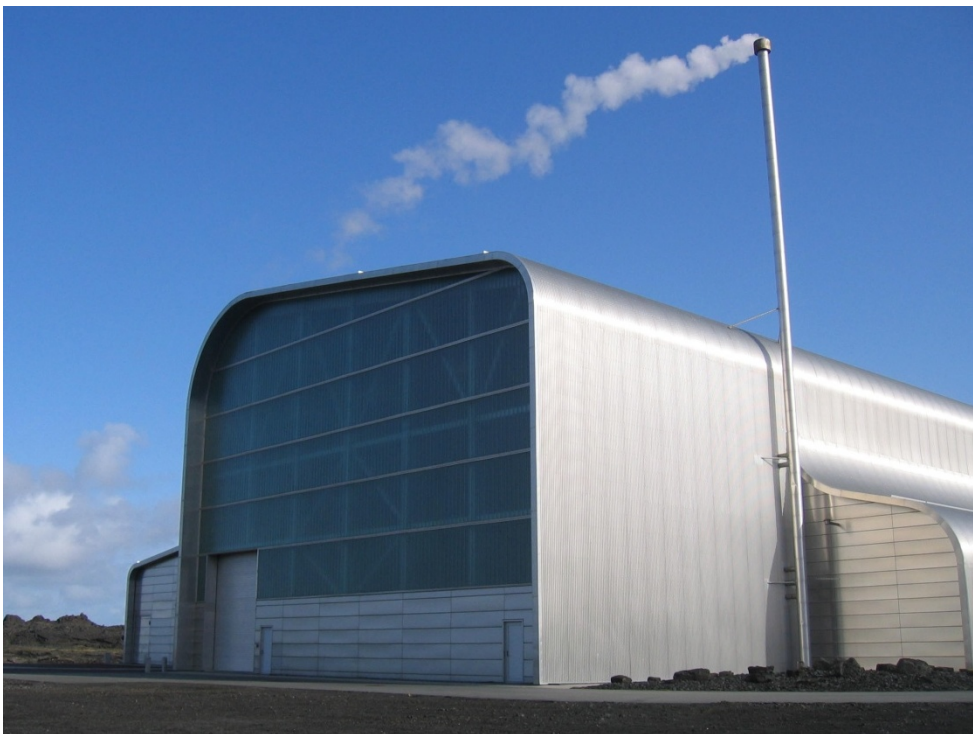
Mynd 8.6 Stöðvarhús Reykjanesvirkjunar.
