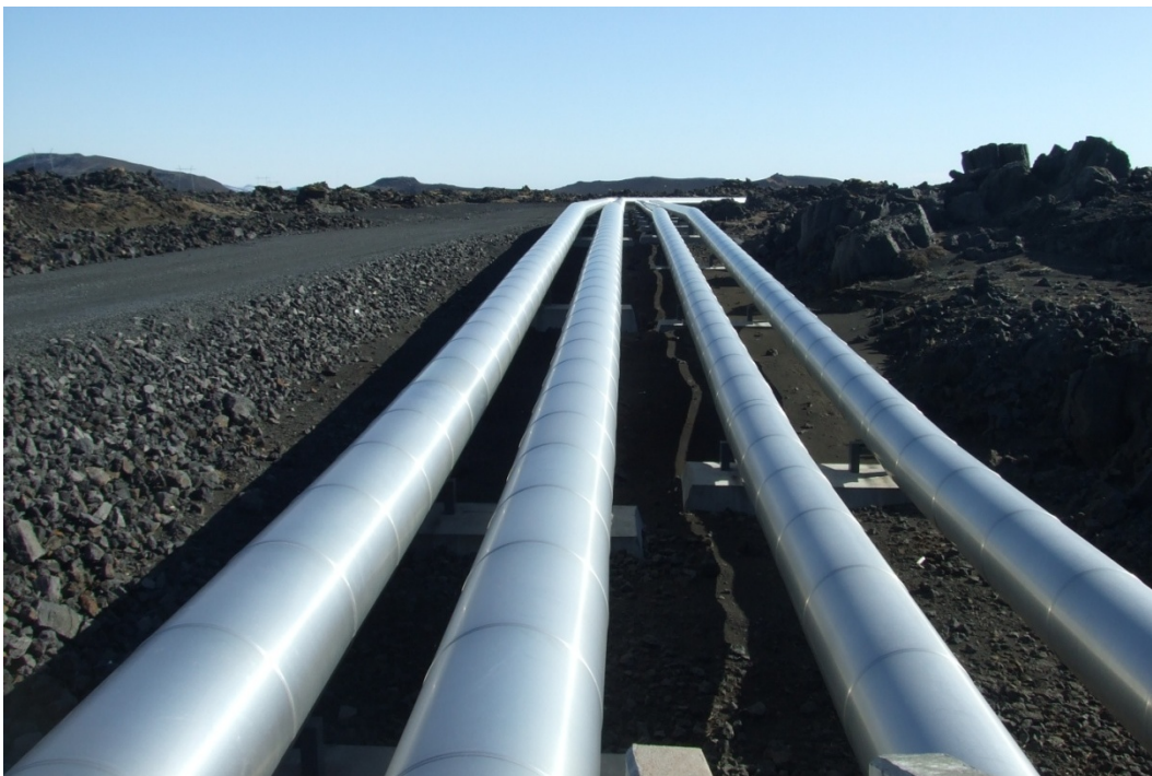
Mynd 8.8 Stofnlagnir jarðhitavökva og gufu sem liggja frá skiljustöð að stöðvarhúsi.
