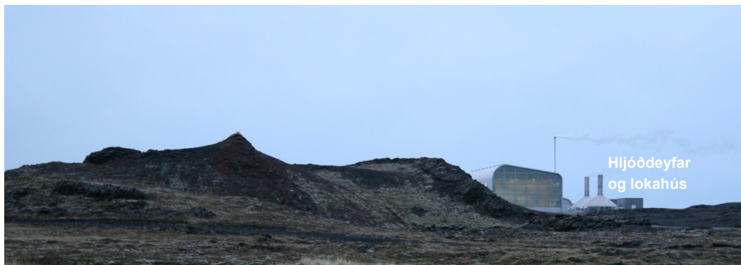
Mynd 8.9 Hljóðdeyfar og lokahús við stöðvarhús Reykjanesvirkjunar.
