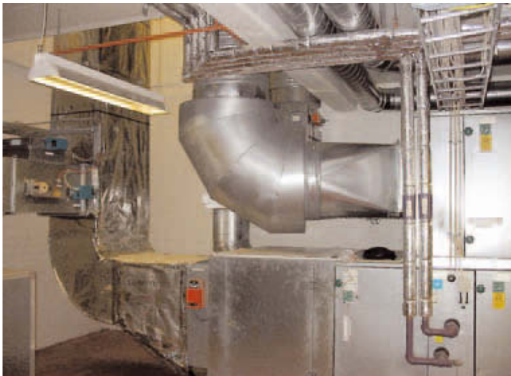
Loft-ræstikerfi umferðarganga Landspítalans við Hringbraut
