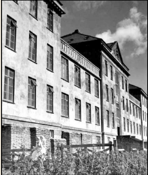
Á þriðja áratug 20. aldar var rætt um að reisa Landspítalann við Laugarnar. Horfið var frá þeirri hugmynd en sjúkráhusið naut hins vegar heita vatnsins frá Laugaveitunni. (Ljósmyndari Þorsteinn Jósefsson - Árbæjarsafn)
