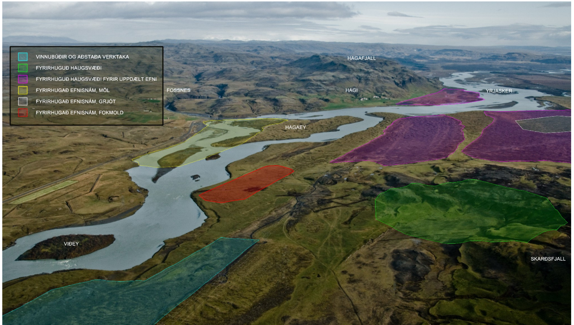
Mynd 5a. Horft í norður. Efnistaka, haugsetning, vinnubúiðir og aðstaða verktaka skv. matasskýrslu.
