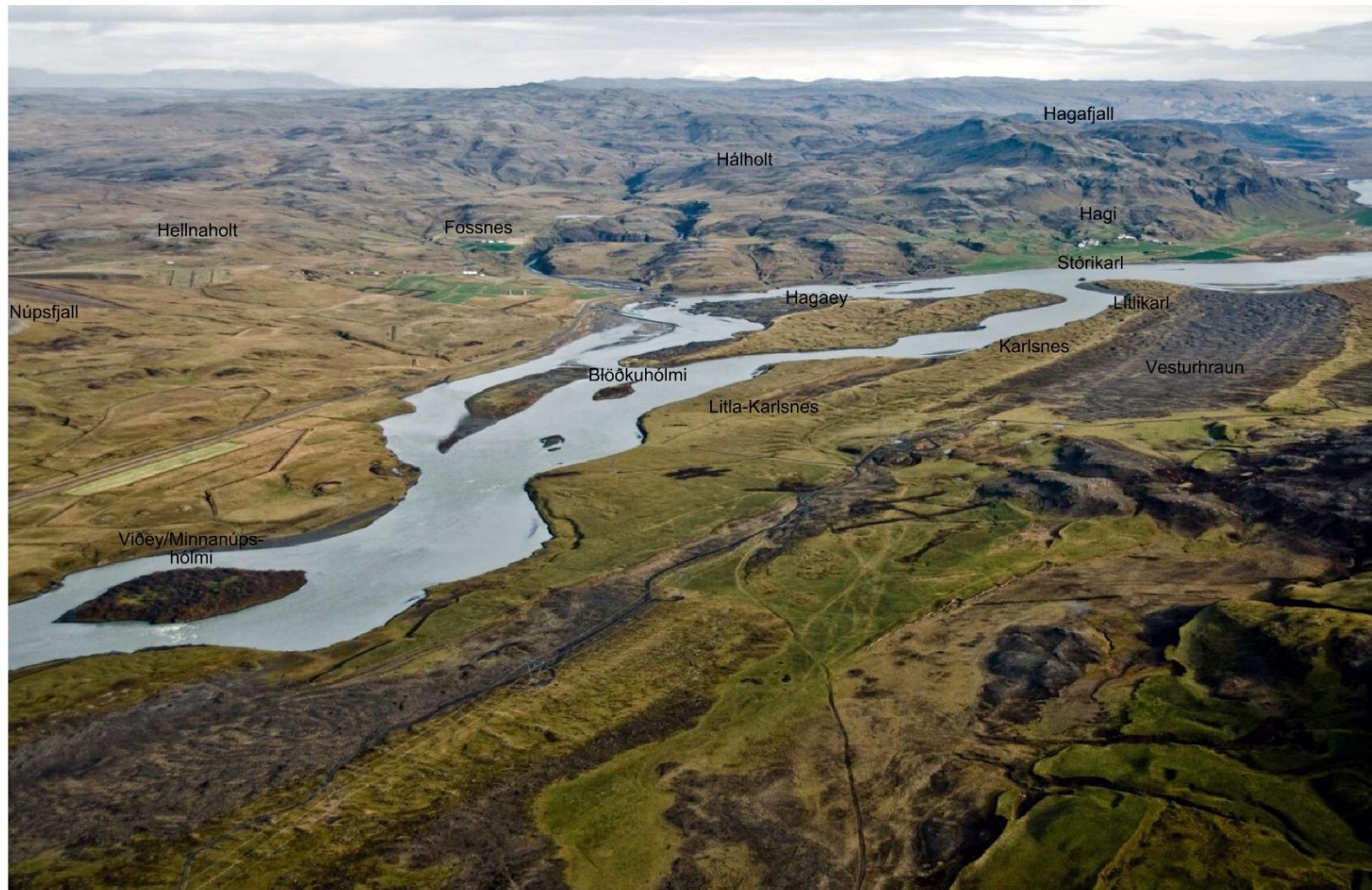
Mynd 1 Þjórsá – yfirlitsmynd. Horft í átt að fyrirhuguðu stíflustæði og inntaksskurði. Mynd: Landsvirkjun. Myndina er að finna Viðauka 1..
