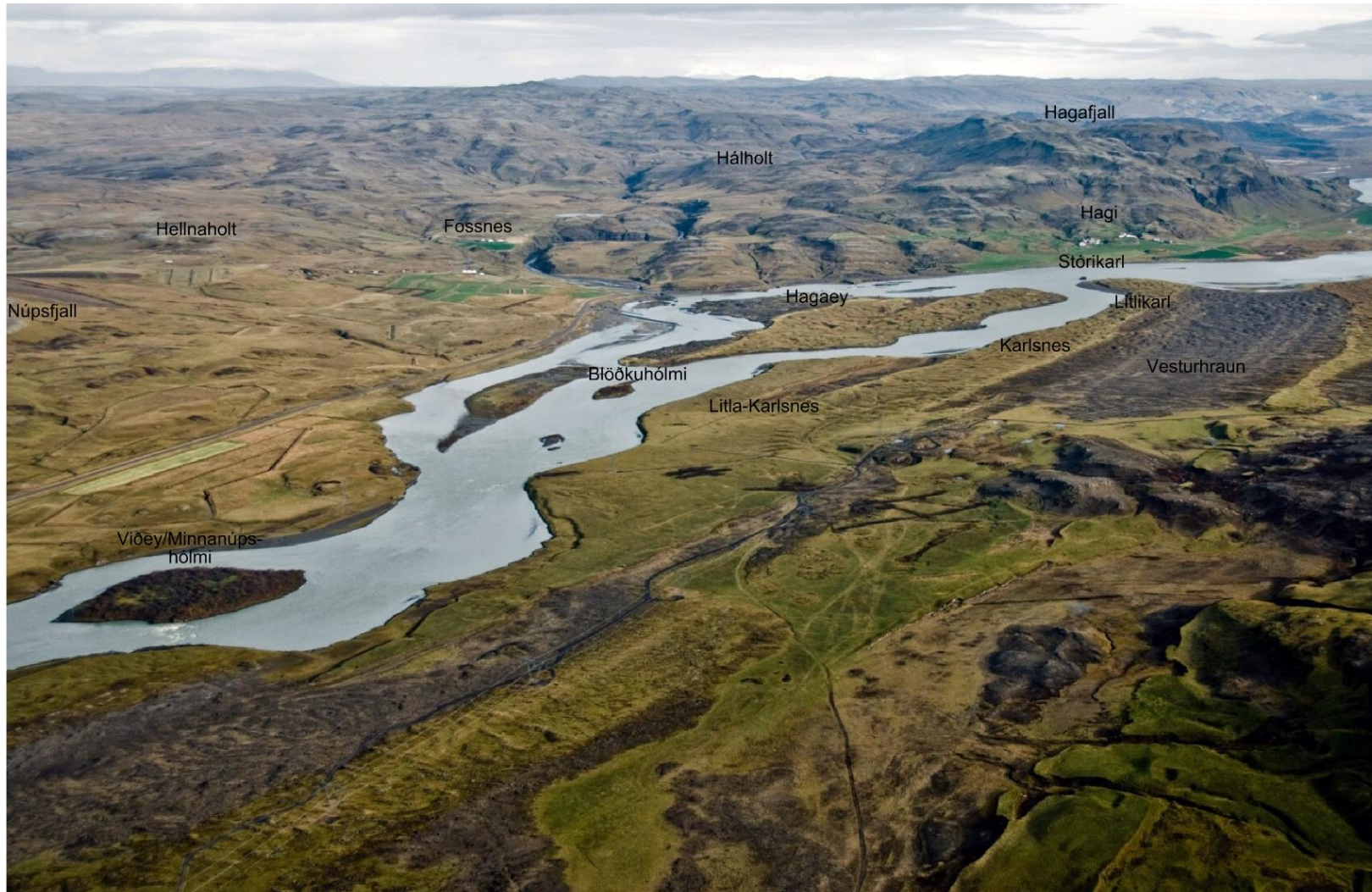
Mynd 1 Bjórsá – yfirlitsmynd. Horft í átt að fyrirhuguðu stíflustæði og inntaksskurði. Mynd: Landsvirkjun.
