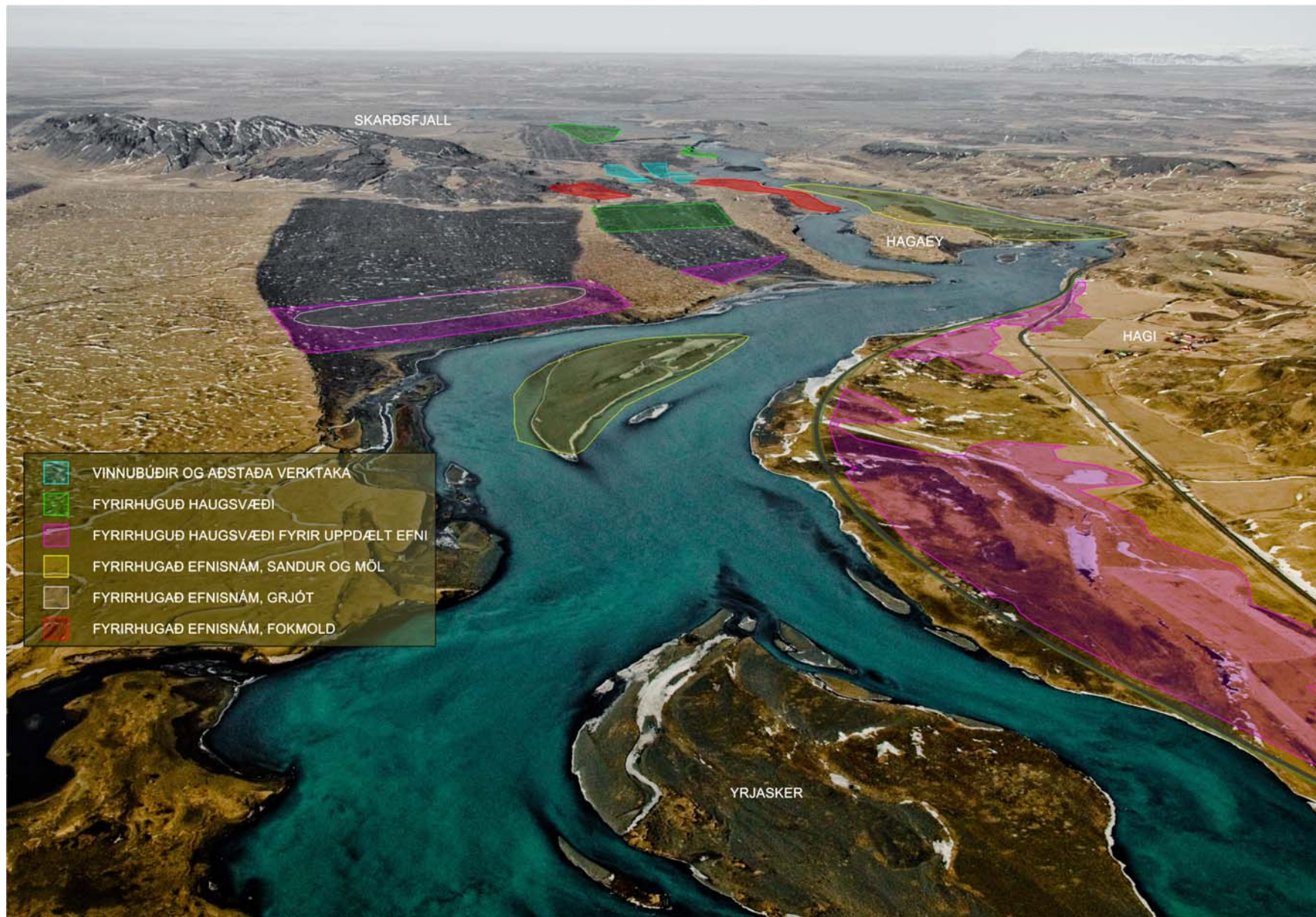
Mynd 5b. Horft í suður. Efnistaka, haugsetning, vinnubúðir og aðstaða verktaka eftir breytingar.
