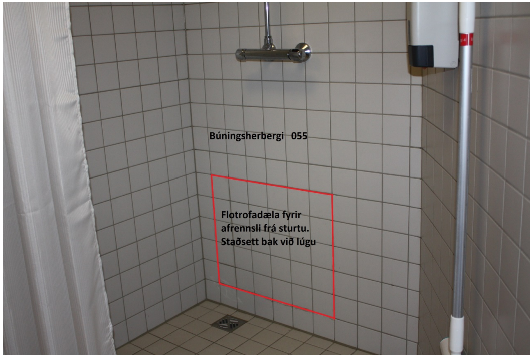
Staðsetning flotrofadælu fyrir frárennsli frá sturtu
