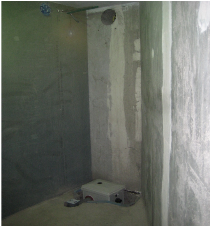
Flotrofadæla fyrir sturtu í herbergi 055
