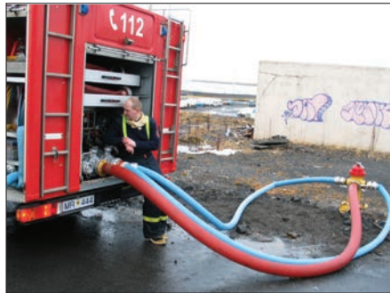
Mynd 5.27 Lagt á vatnshana.
