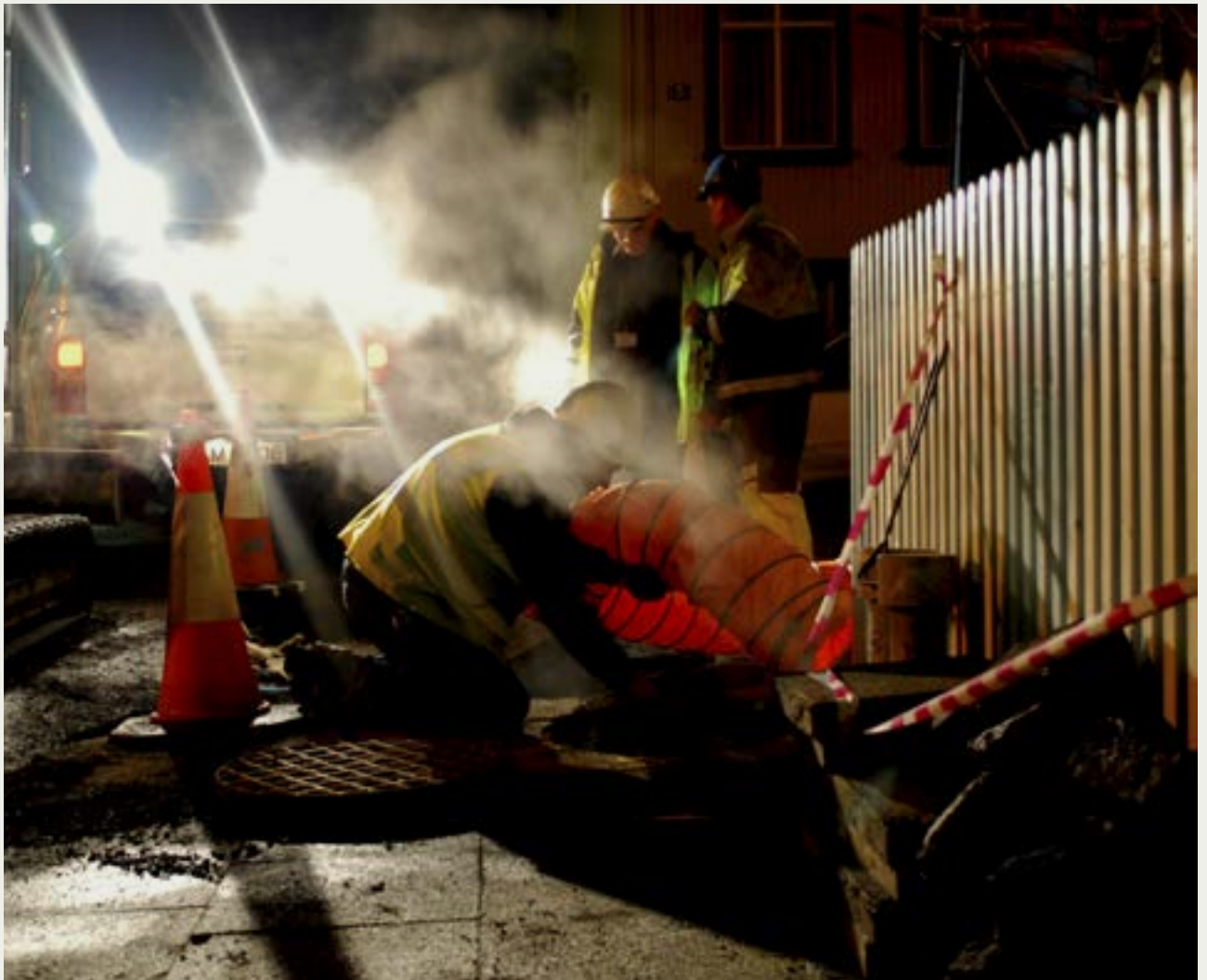
Mynd 11. Unnið að viðgerð á hitaveitulögn.
