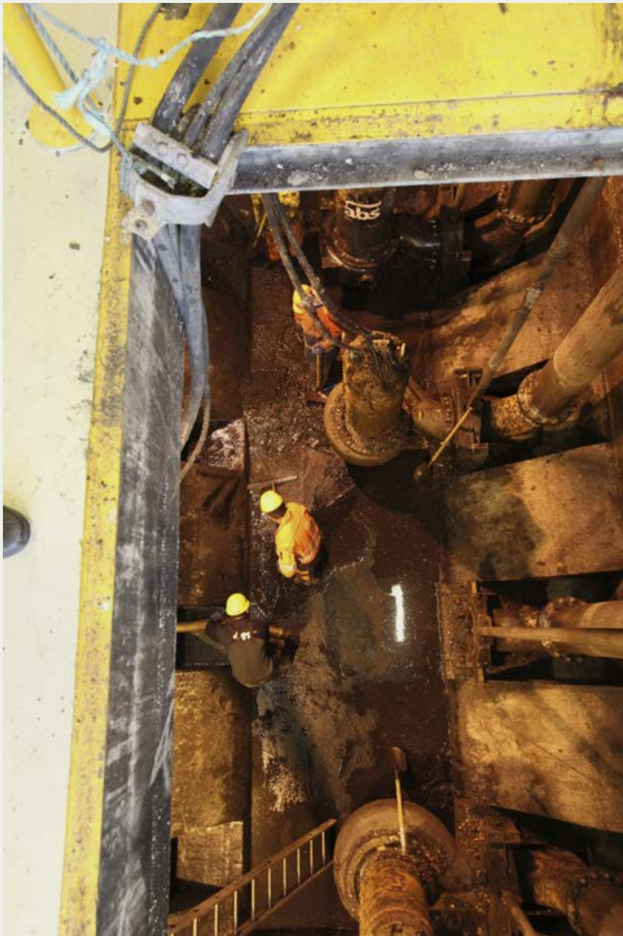
Mynd 25. Unnið við botnhreinsun á próf í dælustöðinni við Faxaskjól.
