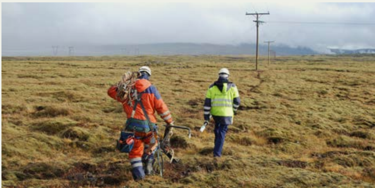
Mynd 10. Starfsmenn Orkuveitu Reykjavíkur sinna viðhaldi á rafmagnslínu í nágrenni við Hellisheiðavirkjun.
