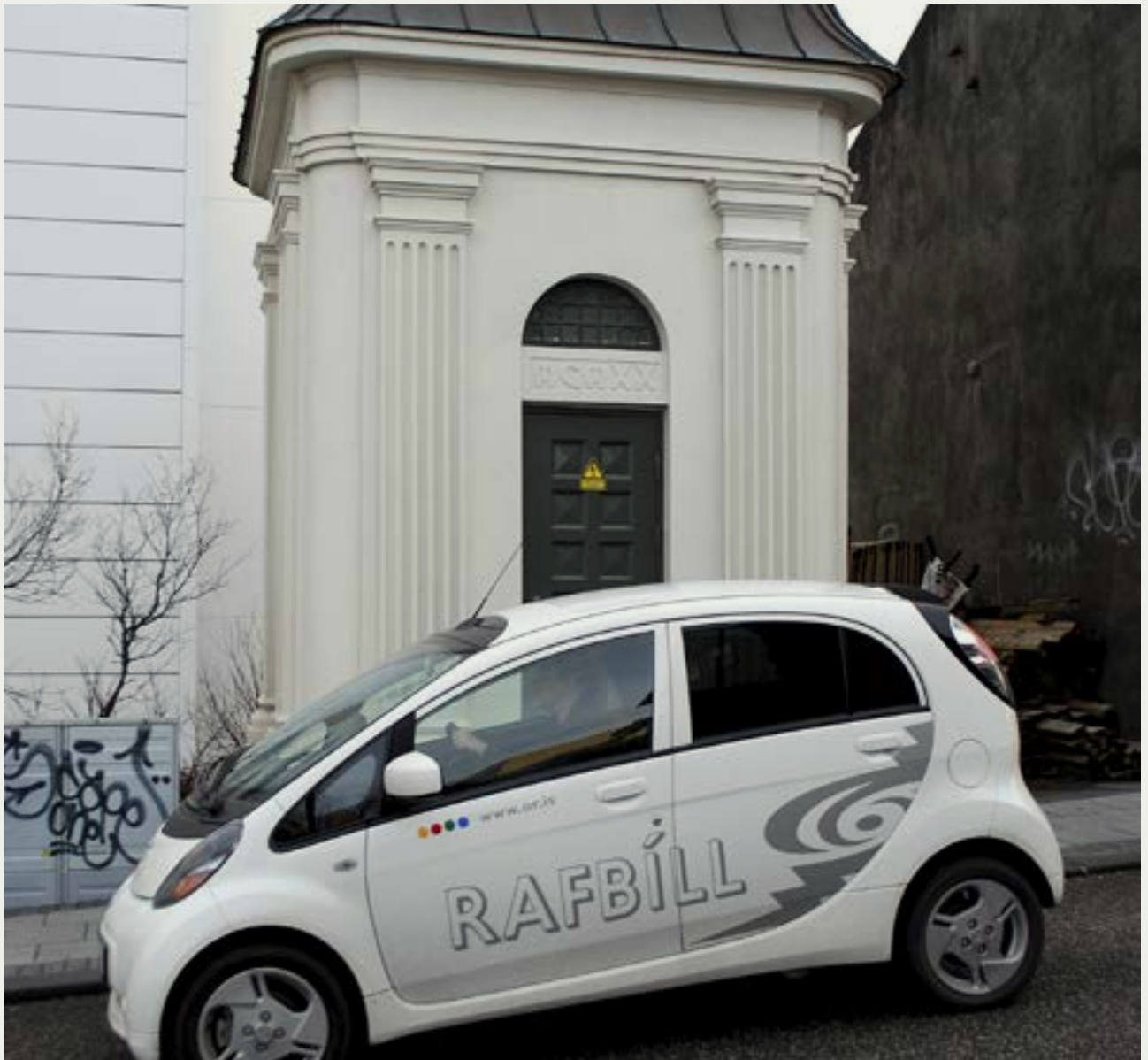
Mynd 31. Nýtt og notað. Rafbíll ágerð 2013 fyrir framan dreifistöð rafmagns á Klapparstíg í Reykjavík sem reist var árið 1921.
