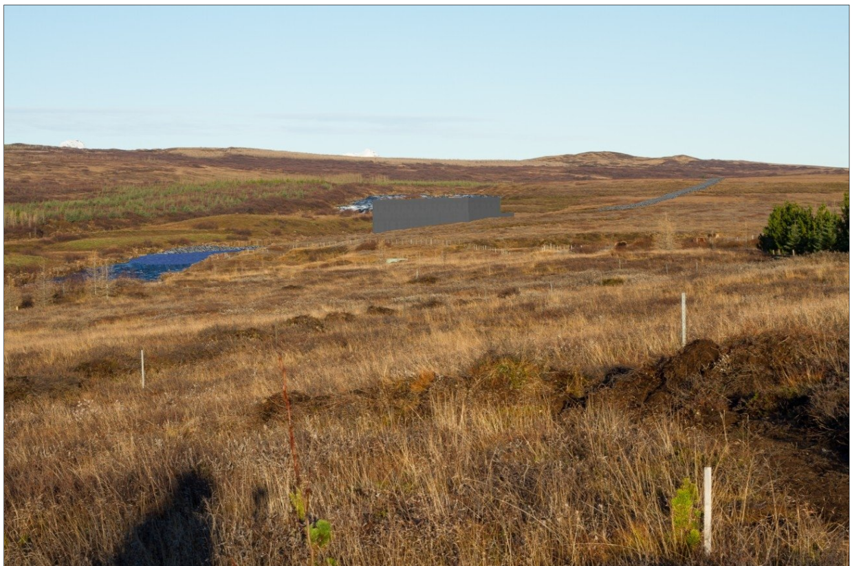
Mynd 4.5 Ásýnd frá húsi á austurbakka Tungufljóts. Stöðvarhúsið sést fyrir miðri neðri mynd og vegur þaðan meðfram niðurgrafinni þrýstípi til norðausturs. Mynd tekin til norðurs af myndatökustað 3 (sjá mynd 4.2).
