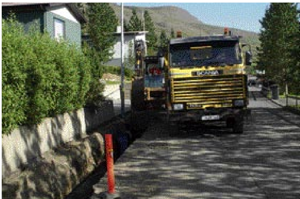
Unnið að lagningu hitaveitu á Eskifirði. Ljósmynd: Pétur Sörensson.
