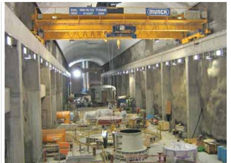
Vélasalur Fljótaldalsstöðvar inni í Valþjófsstaðafjalli
