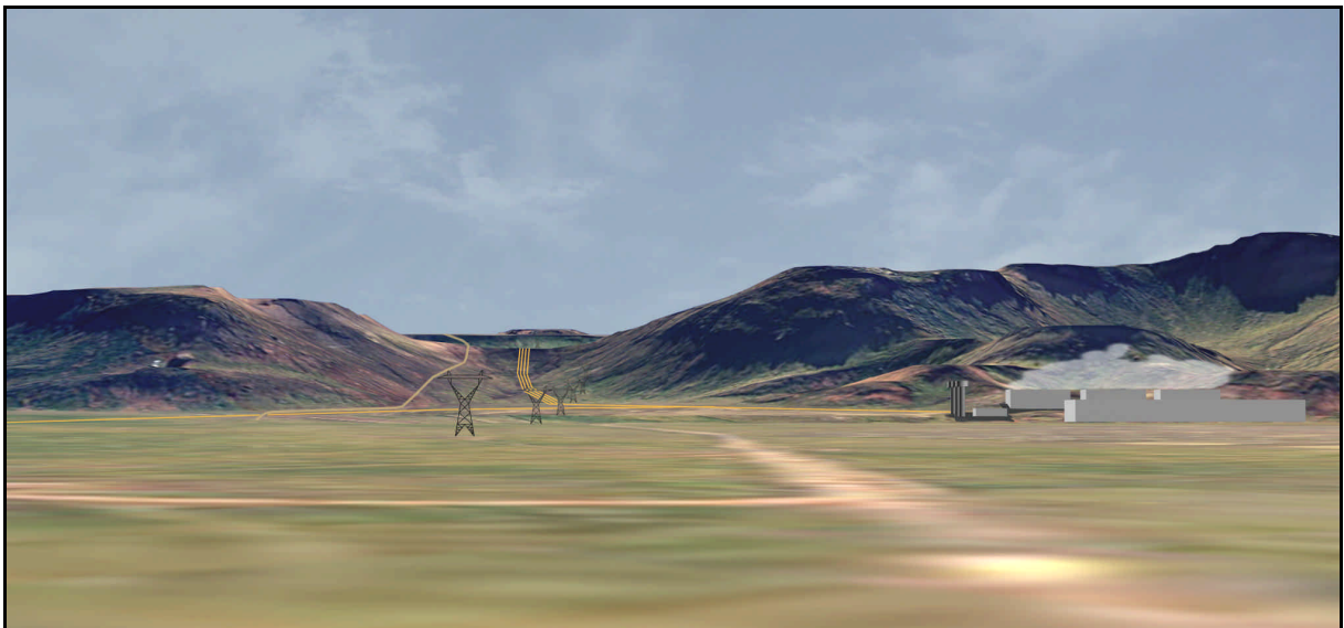
Mynd 43. Tölvugerð mynd, virkjun horft til austurs frá gamla þjóðveginum vestan Kolviðarhóls (kostur I). Aðveituæðar liggja niður Hellisskarð og frá skiljustöðvum, ofan skarðsins og vestan Þverfells, að stöðvarhúsi. Við hlið þess sjást lokahús, þrjár einingar kæliturns og þrjár gufuháfar. Einnig er sýnd veltenging milli efra og neðra virkjunarsvæðis í Hellisskarði.
