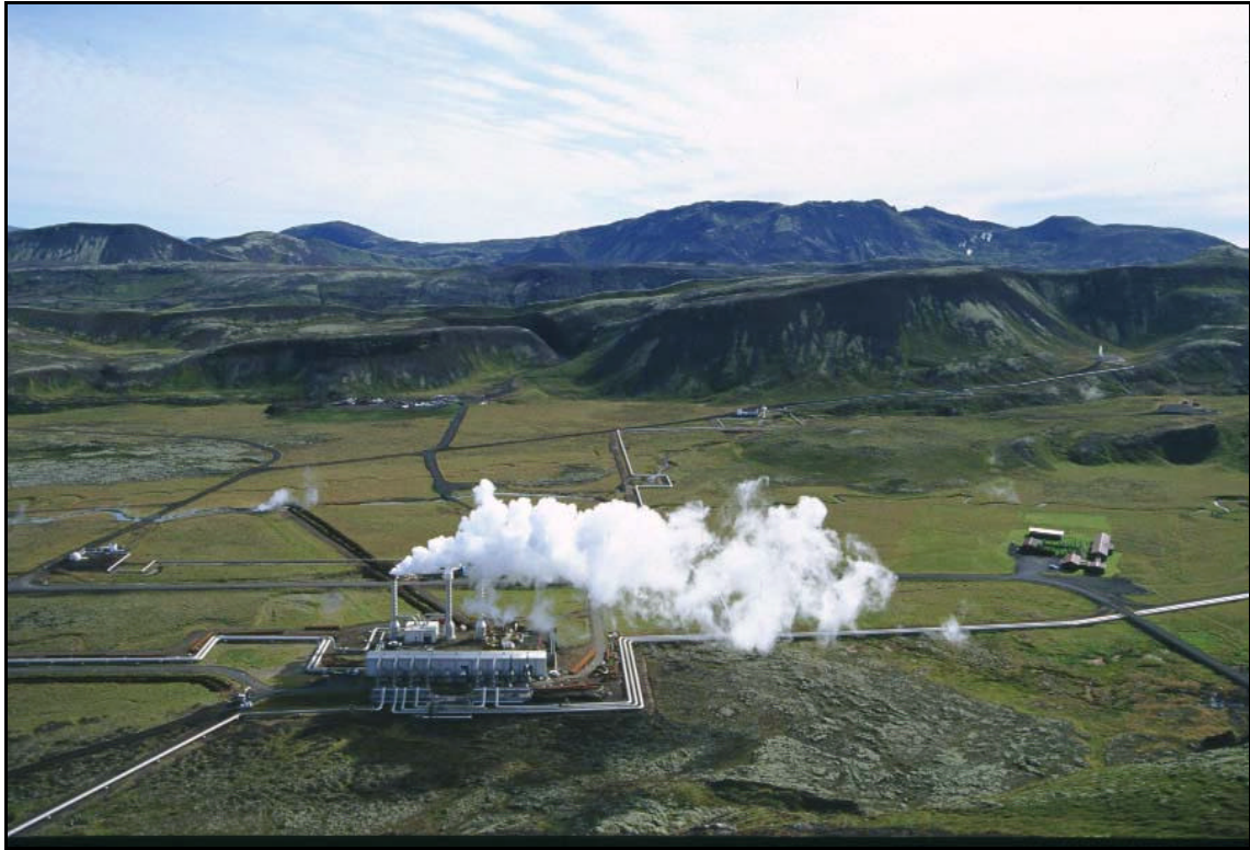
24. ljósmynd. Skiljustöð Nesjavallavirkjunar.
