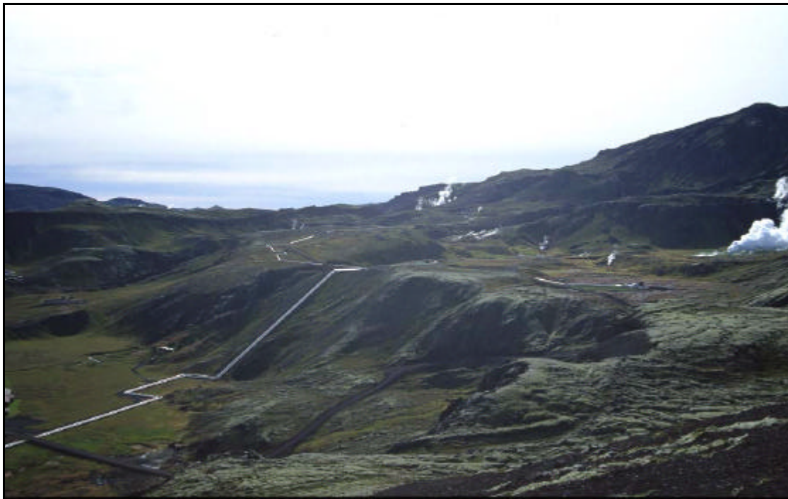
23. ljósmynd. Safnæð ofan Nesjavallavirkjunar. T.h. eru gufumekkir frá blásandi borholu, fyrir miðri mynd sjást gufumekkir frá jarðhitanum í Köldulaugagili og vinstra megin sést í Ölkelduhnjúk og gufur frá jarðhitanum á því svæði ÞEP 2001
